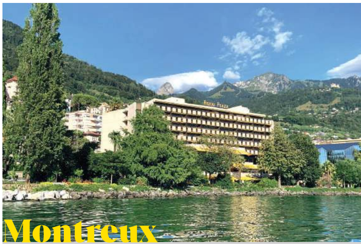
Montreux HÔTEL ROYAL PLAZA Pose de carrelage, façades, livraison des sanitaires.
