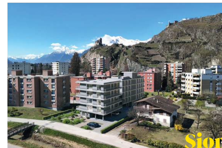
Sion QUARTIER DE VISSIGEN Pose de carrelage, livraison de matériaux, carrelage des salles de bains et des cuisines de plusieurs centaines d'appartements.
