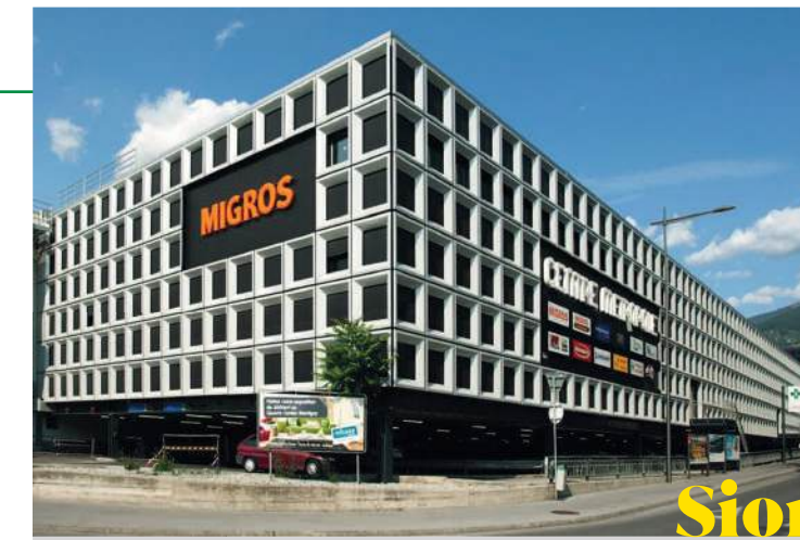
Sion MÉTROPOLE Livraisons et pose carrelage lors de la construction et des rénovations de nombreux Centres Migros en Valais.
