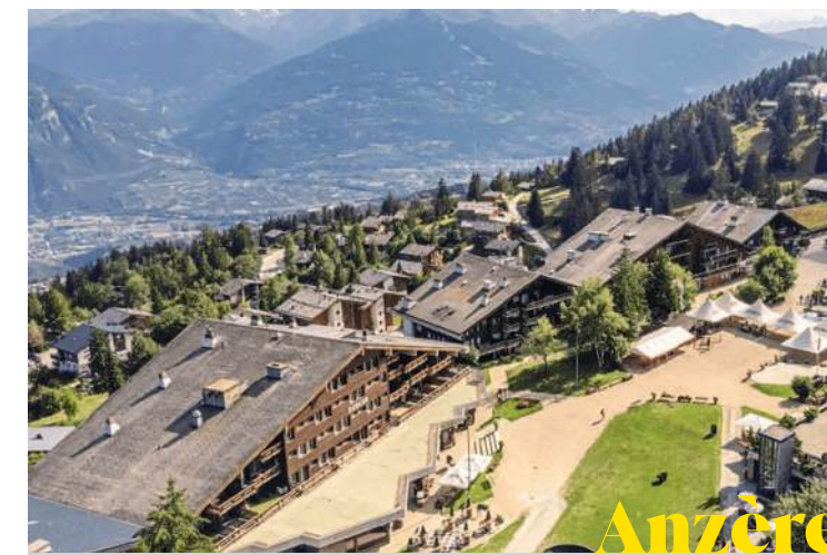
Anzère STATION Pose de carrelage, livraison de matériaux, carrelage des salles de bains et des cuisines de plusieurs centaines d'appartements lors de la construction et de la rénovation.
