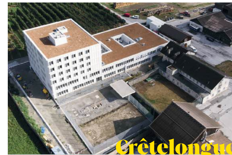
Crêtelongue NOUVEAUX BÂTIMENTS POUR LA PRISON VALAISANNE Livraison de matériaux, plâtre.
