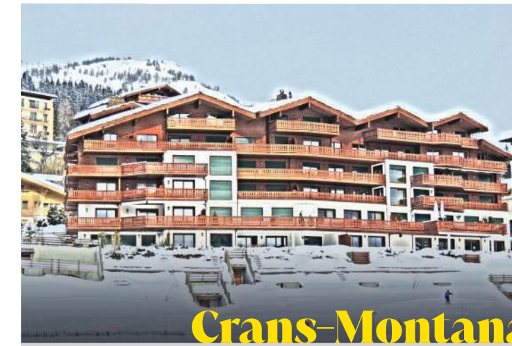
Crans-Montana RÉSIDENCE EXCELSIOR Pose de carrelage, livraison de matériaux, carrelage des salles de bains et des cuisines.
